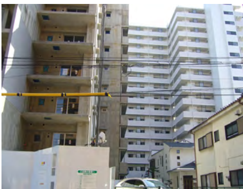
高崎市中心街、リーマンショックで倒産したマンション2例。奥の高層マンションはアウトレット販売に。手前マンションは工事途中で倒産。足場は外されている。
