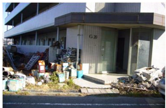
1991年竣工、5階建て20戸、調整区域、開発業者は倒産、管理組合は崩壊、水道・下水が使えず、エレベーターも停止、最近5年間で10戸が競売、落札は1戸
