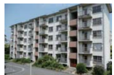
RCラーメン構造棟
